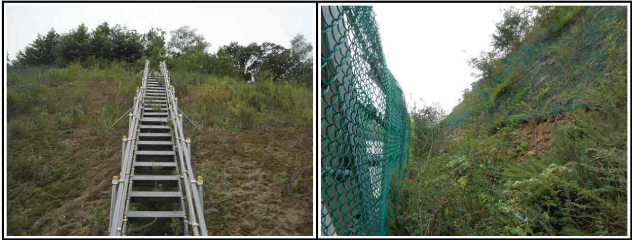
【그림 4.3.4】 보호/보강시설 전경
